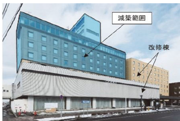
写真-2 既存ホテルの減築範囲
