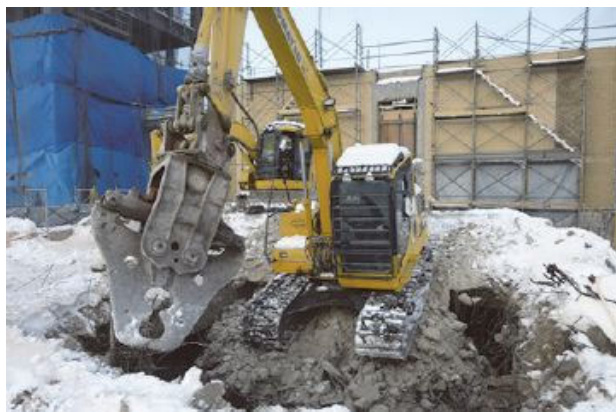
写真-7 コンクリート塊のスロープで階下へ移動
