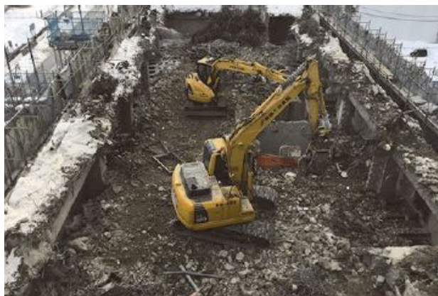
写真-6 解体状況 (内部の解体完了)
