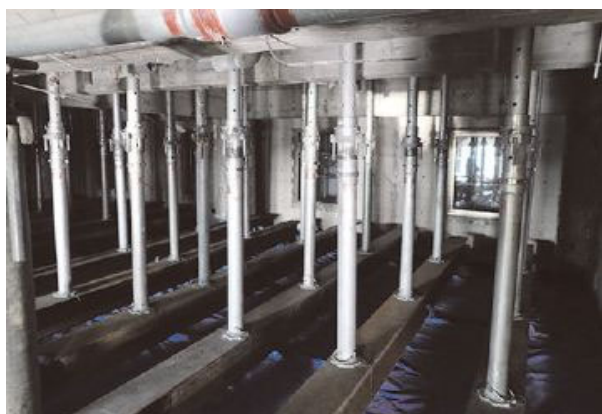
写真-4 5階床下のH型鋼と補強用サポート
