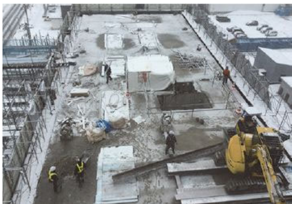
写真-10 5階床上の H 型鋼材撤去
