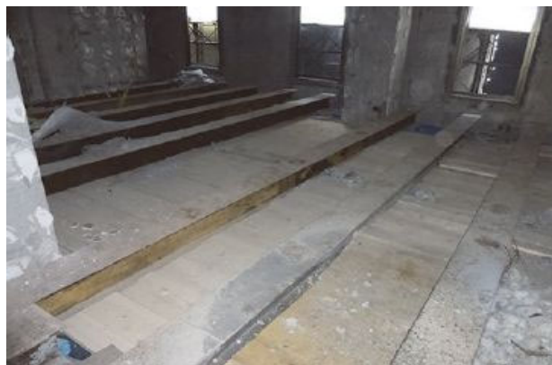
写真-5 H型鋼間に敷いたガラ落下防止用矢板
